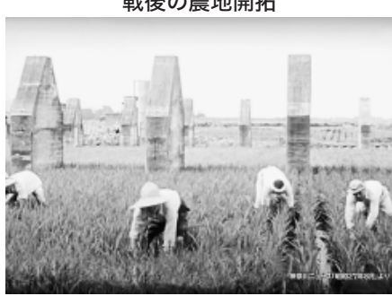
(後ろに立つのは格納庫の基礎) 写真提供: 神奈川県
